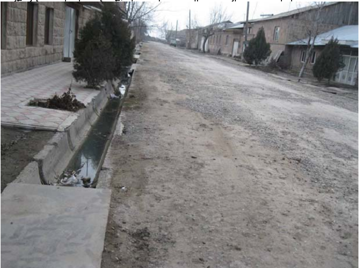
Քայքայված ա/բ պատվածք, հիմնականում գրունտային ճանապարհ
