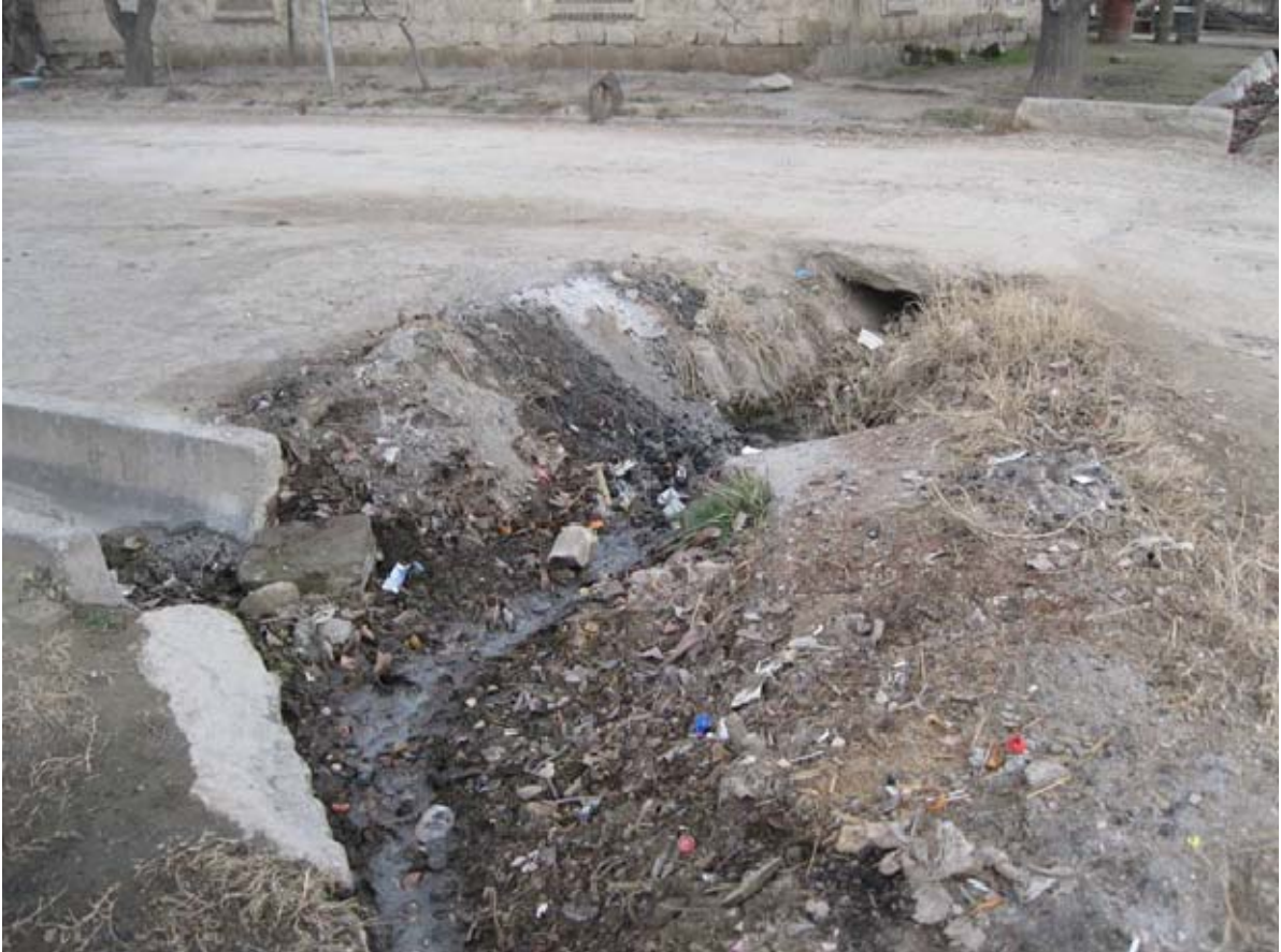
Քայքայված ա/բ պատվածք, հիմնականում գրունտային ճանապարհ
