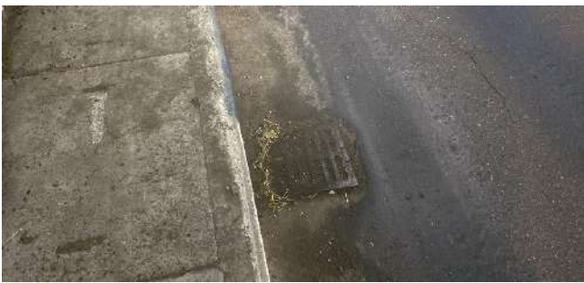
Պատկեր 5: Ամբողջությամբ արգելափակված կողային ջրահեռացման դիտահոր
