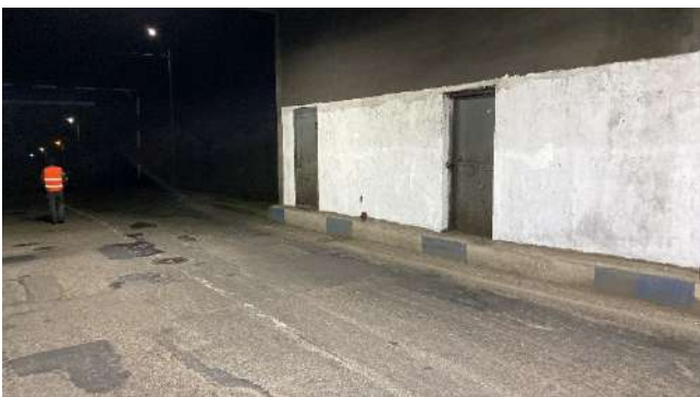
Պատկեր 7: Տեղային լայնածավալ վերանորոգում և թունելի ցածր որակի ճանապարհ
