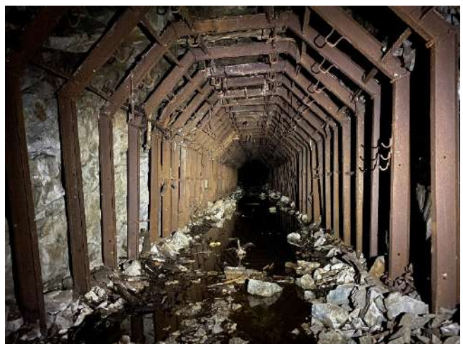
Պատկեր 8: Զուգահեռ թունել առանց հենարանների (բացառությամբ պրոֆիլի համար պողպատե կողերի), տեսանելի են խոշոր քարերի փլուզումներ
