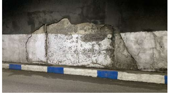
Պատկեր 4: Տորկրետ բետոնե պաշտպանիչ ծածկույթի շերտազատման նմուշ՝ ջրի ներթափանցման արդյունքում
