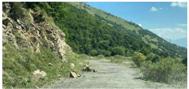
Պատկեր 6: Քարաթափում շրջանցիկ ճանապարհի վրա, նեղ և ցածրորակ ճանապարհահատված
