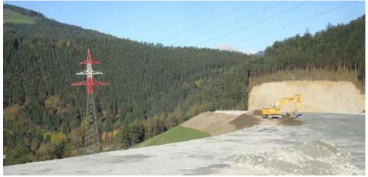
Պատկեր 16: Հանույթի տեղակայման տարածքի վերականգնում: Տեսանելի շերտեր՝ հանույթ (մոխրագույն), սահմանային հողի շերտ (բաց շագանակագույն), հումուսի շերտ (մուգ շագանակագույն), սերմանված շերտ (կանաչ)
